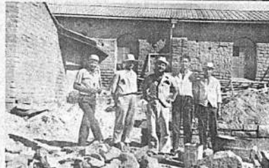
Obras en Pampa Grande
