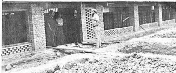
La fábrica de cerámica cuenta con una producción de mil ladrillos por hora.
