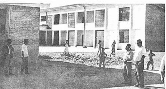
Los servicios higiénicos del Liceo de Srta. Avelina Arraya, (izquierda) han tenido que ser clausurados por la falta de agua ocasionando incomodidades en las alumnas que ibán desde varios puntos de la ciudad.
