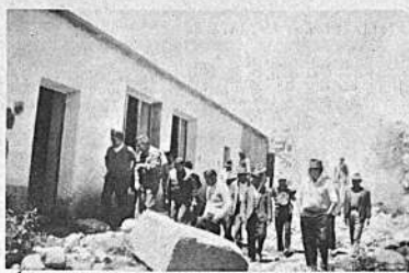
El Prefecto de Potosí, Dr. Mario Hurtado Ibáñez, realizó una extensa gira para evaluar las necesidades de las provincias. Arriba, inspecciona el nuevo local escolar que se construye en La Lave.
