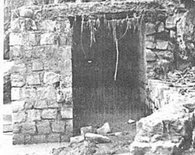
GUANAY. Las fuertes riadas destruyeron la planta hidroeléctrica de Tomachi, en la población del Guanay. Una comisión oficial comprobó en el lugar las pérdidas. La Prefectura notó la situación y se comprometió a cumplir su compromiso de mantener en funcionamiento dicha planta que suministra energía eléctrica a dicha localidad.
