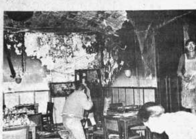
La explosión de una cocina por el exceso de presión provocó, ayer por la mañana, un incendio en la cantinilla ubicada en la esquina Comercio y Pichincha, causando daños materiales por unos 40.000 pesos en el inmueble. La rápida intervención de los bomberos impidió que el desastre tomara proporciones peligrosas para el local y los empleados que se encontraban en el momento del siniestro.
