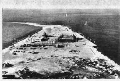
VISTA AEREA DE LA PLANTA DE KEY WEST, Florida, la cual ha alcanzado gran éxito en la conversión del agua salada de mar en agua potable. En el proceso de destilación una diferente etapa y este método le permitió obtener el 70 por ciento del agua de mar que se destila en el mundo. Internacionalmente, cerca de 700 plantas desaladoras, proveen en la actualidad 959 millones de litros de agua fresca, diariamente. Se esperan los próximos años un importante incremento en el número de plantas de esta naturaleza.
