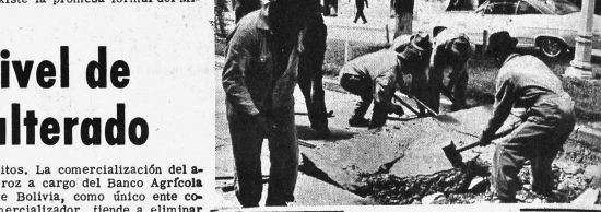
ADOQUINADO DE AVENIDA AMERICA. Comenzaron los trabajos de adoquinado de la Avenida "América", emprendida por la Alcaldía Municipal, en una empresa constructora privada. Las obras incluyen el ensanche de la vía para facilitar el tráfico de vehículos. Los trabajos determinan que cada una de las vías de dicha avenida debe actualizarse en 5 metros de anchura, reduciendo la superficie anteriormente ocupada por el terreno central. El costo de tales obras, incluyendo el movimiento de tierra y la habitación del sistema eléctrico, asciende a 69,836 pesos bolivianos.
