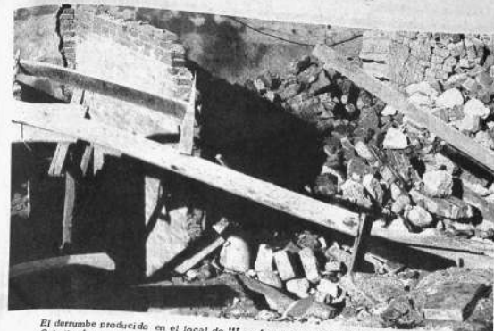
El derrumbe producido en el local de "Los Amigos de la Ciudad" perjudicó también al que se estaban construyendo en el mencionado edificio, "Los Amigos de la Ciudad" en una institución que se preocupa por el buen estado de la capital.
