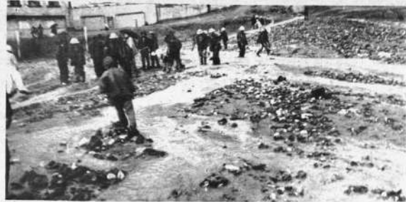
En la fotografía se observa el trabajo realizado por las cuadrillas de emergencia de la Municipalidad y de Bomberos, en su afán de limpiar los canales de desagüe, obstruidos por las torrenciales lluvias caídas durante los últimos 48 horas en distintas zonas de la ciudad.
