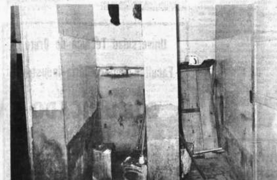
Esta fotografía corresponde a la sala de pediatría del Hospital de Clínicas. Es difícil apreciar la deficiencia del mobiliario y su pobreza.
