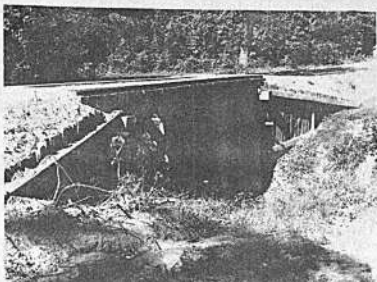
-Cobija, (PRESENCIA).- El Prefecto del Departamento inauguró el puente sobre el arroyo "Trizas del Acre". Fue construido con fondos del Comité de Obras Públicas de Pando y la Prefectura. La inauguración estuvo a cargo del Dr. Felipe Saucedo, Prefecto de Pando. El puente en la fotografía vincula el importante núcleo campesino "Najío Virtudes" con la capital pandina.
