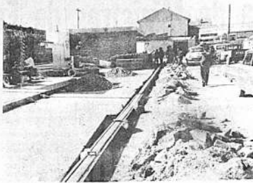
Ampliación de aceras, resellado de pavimento y construcción de un mirador en la zona de la comuna orurina en la plaza de esparcimiento "Acahuasi". Las obras serán entregadas el próximo 10 de febrero.
