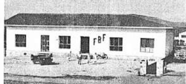
COOPERATIVIZACION.- Santa Cruz (PRESENCIA). Este es el centro de comercialización de la Fundación Baviera de Fomento, entidad que ha donado que cooperativistas sus instalaciones, en las que ha invertido 500 mil dólares. Arriba, en la fotografía, el interior del almacén de consumo. Abajo, vista del almacén construido con donaciones de la población alemana.
