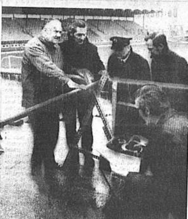
BARRERAS DE CONTENCIÓN. Coventry, Inglaterra, 8 (AP). Después del desastre de fútbol en Glasgow donde 66 personas perdieron la vida, muchos equipos ensayaron las barreras de contención. El ingeniero Lance Mays mide la resistencia de una barrera en la cancha del equipo de Coventry (Radiofotografía AP).
