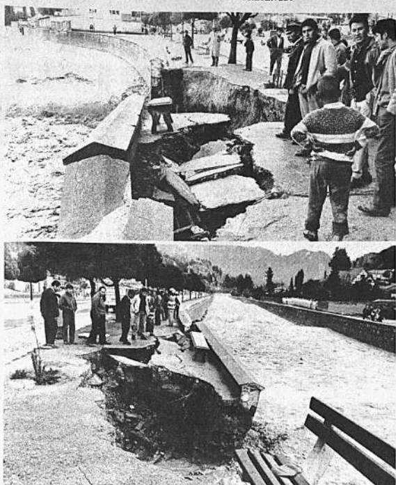
Una parte de la canalización del río Chichiquay, 50 metros más abajo de la ganadería de Obispo, quedó rota por el embate de las aguas del río, durante la lluvia de ayer. El año pasado se había presentado en ese lugar un "sifonamiento". El río fue socavando a lo largo de los meses, el muro de contención, hasta que ayer se desplomó arrojando un sector de la azar. Aguas arriba, a la altura de la plaza principal de Sucre, el pretil de la canalización había sido roto para cerrar por la apertura tierra de unos metros que allí se efectuó. El canal del río venció la debilidad estructural y se desbordó inundando el Instituto Educativo que funcionó en ese lugar. Varias aulas quedaron inutilizadas. Ayer, cuando los ingenieros municipales se hicieron presentes, vecinos del final de Obispo se expresaron su temor de que el muro de la canalización continúe cayendo, en cuyo caso el Chichiquay desbordaría todo el barrio del Paraisito. A la larga de la canalización se han presentado varios desperfectos, los cuales no fueron oportunamente reparados. Así, por ejemplo, a la altura del panteón que una la Avenida Roma con Segura, a la altura de la Academia Nacional de Policía, existen algunos desperfectos sobre el muro izquierdo. Algunos de ellos, que observamos ayer, desplome, aseguran que cuando se efectuaron reparaciones en esa parte, no hubo un buen relleno de tierra y que tampoco se habían reforzado los cimientos del muro, el cual debilitado en esa forma, cedió ayer ante la fuerza corriente.
