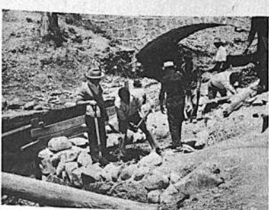
Vicinos de Alto Miraflores trabajan intensamente sobre el río Guirra, donde se construye un puente vehicular, bajo un programa conjunto entre el Municipio de La Paz y la Junta de Vecinos y el Plan de Población.
