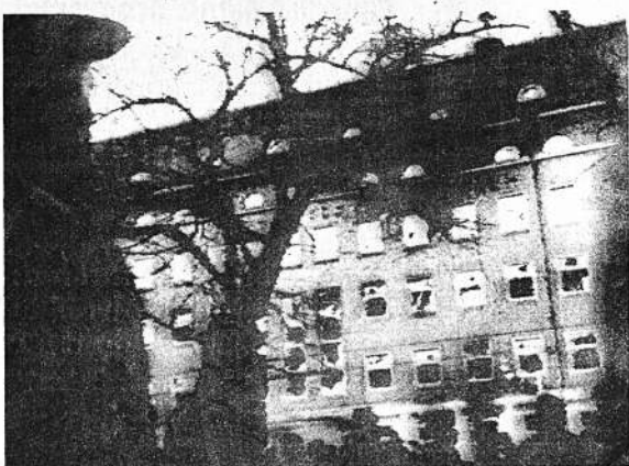
INCENDIOS EN POLONIA, Malmoe, Polonia, 18 (AP). - Muchas casas en Szczecin, Polonia, fueron incendiadas durante los disturbios. Los vidrios de las ventanas fueron rotos. Los desórdenes han afectado a las tres ciudades bálticas de Gdansk, Gdynia y Sopot y provocaron una situación similar en Szczecin, en la parte occidental de Polonia, el jueves por la noche (Radiofoto, Especial para Presencia, Bolivia).
