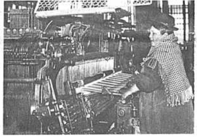
La fábrica Soligno está en plena etapa de rehabilitación. Hay confianza sobre su futuro. Uno de los aspectos más positivos para ese propósito es el concurso y aporte de empleados y obreros.
