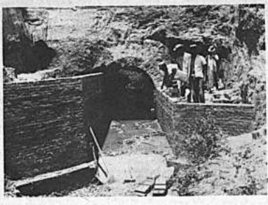
En la ciudad de Cobija prosiguen los trabajos del alcantarillado en la Avenida Fernando Molina, a cargo del Comité de Obras Públicas dependiente de la Prefectura. Las obras están concluidas hasta fin del presente mes.
