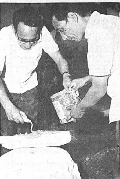
El Lic. Jaime Sandy Gumucio coloca la primera piedra para el edificio de la Aduana en la frontera de Puerto Suárez.
