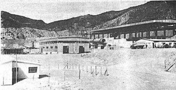
Vista panorámica de las instalaciones y el horno de calcinación de la nueva fábrica de cemento, COBOCE, en Ip'a, Cochabamba. Esta obra es resultado del esfuerzo cooperativista, flace poco los maestros adquirieron una cantidad apreciable de acciones.
