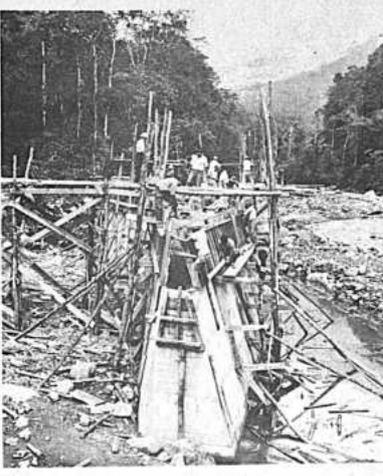
Construcción de estribos en el puente sobre el río Espiritu Santo Tercer, en el Proyecto Vial Cuatro.
