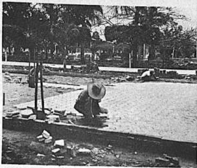
La fotografía muestra los trabajos de enlaseado en las calles de Riberalta. Los Alcaides y los pobladores de esa ciudad han iniciado diferentes obras de mejoramiento urbano.
