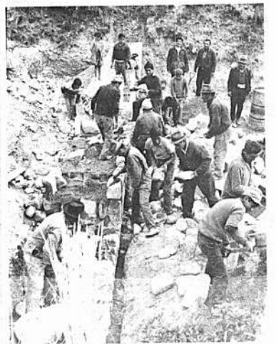
La participación voluntaria de los vecinos de la zona "Corazón de Jesús", dentro del Programa de Acción Comunal, hace posible la construcción de muros de contención, que servirán de protección para los huertos de los habitantes de la zona durante la época de lluvias. Similares obras se ejecutaron en varias zonas marginales de la ciudad.
