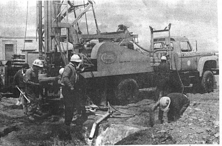
Un moderno equipo de perforación utilizado en los trabajos de proyecto, permitiendo la apertura de pozos de agua en las mismas zonas de actividad agrícola, facilitando el transporte y empleo de líquido elemento.
