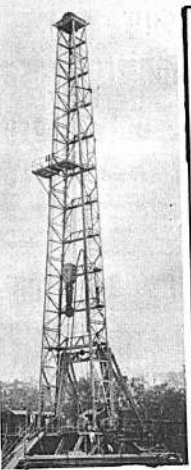
Concluyó la perforación del pozo No. 6 con una producción diaria de 1,117 barriles de petróleo y 2,300,000 pies cúbicos de gas, la torre de perforación es desmantelada para iniciar un trabajo inmediato. (FOTO PRESENCIA)
