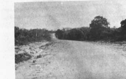
SECTOR DEL CAMINO COBIJA-PORVENIR En construcción por el Bat. de Ingenieros Long. 32 km. Derecha de vía 40 mts. Pisoforma 10 mts.
