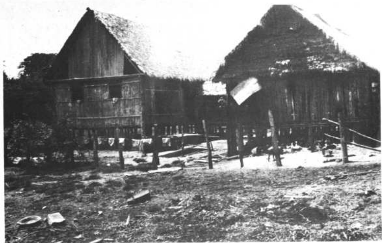
FRONTERAS DE BOLIVIA Y DE LA MISERIA.- Esto también es Pando: casuchas o "taperas" construidas al borde de los ríos, elevadas por troncos para evitar ser destruidas por las frecuentes inundaciones. Aparte de la influencia extranjera, muchas veces denunciada pero jamás solucionada, Pando aparece como la centinela de Bolivia. Si fuera cierto que todo este rico territorio pertenece a Bolivia porque está en nuestro mapa, pero fundamentalmente porque allí - y esto casi resultaría inexplicable - se respira nacionalidad.
