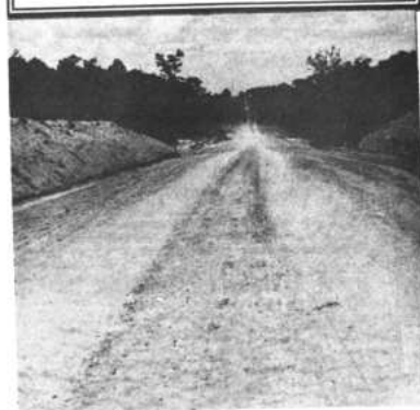
El camino Cobiya-Parvenir está actualmente en construcción a cargo del Batallón "Riosinho 6º de Ingeniería".
