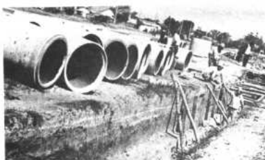
Cuatro barrios marginales cruceños -alrededor de 14 mil personas- tendrán a partir de hoy agua potable. El servicio de extensión ha sido ya concluido, debiendo ser inaugurado hoy. Simultáneamente, continúan los trabajos destinados a llevar agua potable a otras zonas. En la fotografía, un alto en los trabajos de colocación de tubos.
