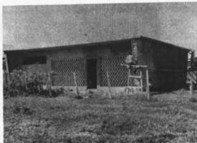
Vivienda Médica - Cobija Avance de Obra 73,42 %
