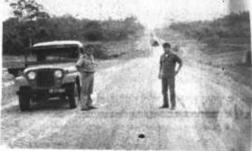
El Comandante del Batallón de Ingeniería durante una inspección de los trabajos.
