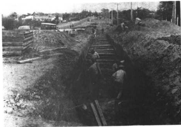
ALCANTARILLADO. — La obra más importante en este rubro es la construcción del sistema emisario y planta de tratamiento de los aguas servidas. Se pondrá en funcionamiento a fin de año.
