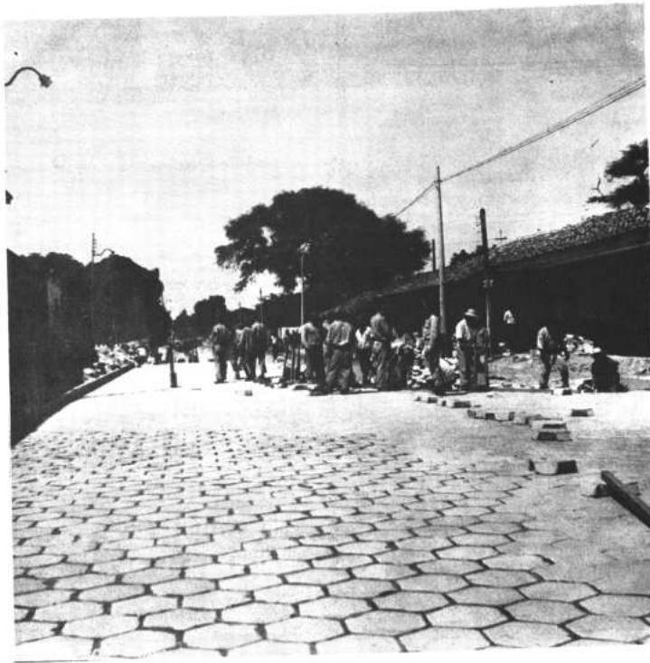
PAVIMENTACION. — Se pavimentaron 80.000 metros cuadrados con losetas y 35.000 metros cuadrados con asfalto. Inversión $b. 8.500.000
