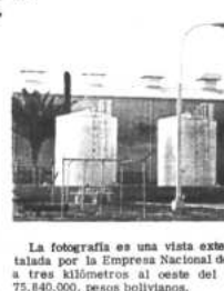
La fotografía es una vista exterior de la planta termoelectrica instalada por la Empresa Nacional de Electricidad (ENDE) en Santa Cruz, a tres kilómetros al oeste del centro de la ciudad. La planta costó 75.640.000 pesos bolivianos.
