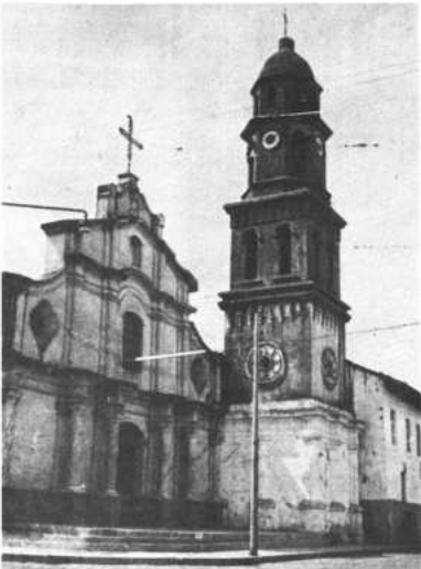
En la fotografía, la iglesia de San Francisco. Como casi en todos los templos cruceros, su construcción se remonta a la colonia. Sólo refacciones para mantenerla en buen estado permiten que ellas sigan cumpliendo sus funciones.
