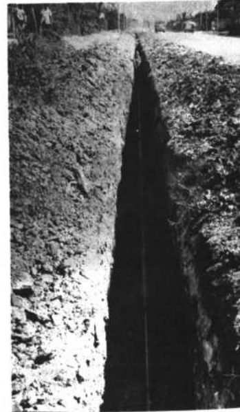
AGUA POTABLE. — Se construyó la Estación de Bombeo y Alcantarillado. Se perforaron dos nuevos pozos para aumentar el caudal de agua que consume la población. El tendido de cañerías y complementarias alcanzó a 35.000 metros lineales. Se adquirieron medidores y cañerías y actualmente se encuentra en plena ejecución el contrato que comprende la dotación de agua a los barrios populares marginales de la ciudad. Inversión $b. 1.500.000.-
