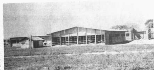
Centro de Salud/Hospital Cobija. Avance de obra 40,28 por ciento.
