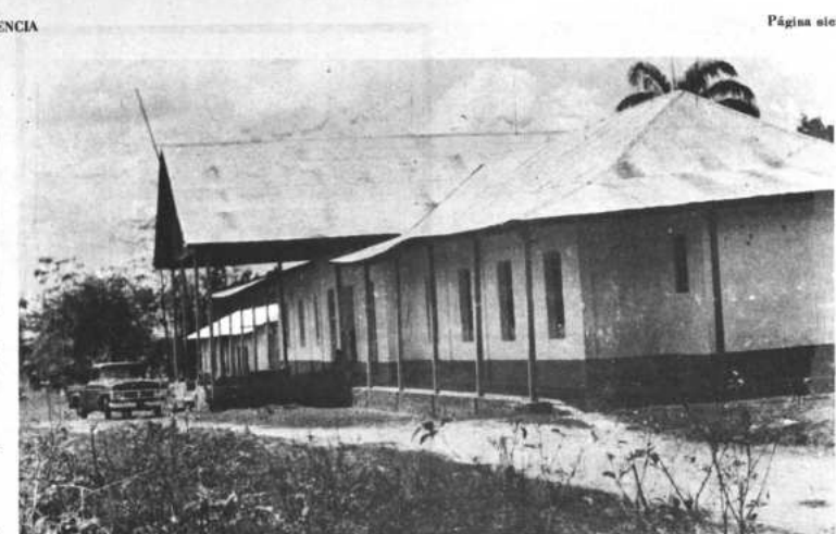
Este es el hospital que funciona en la ciudad de Cobiya. Por falta de medios, los médicos poco pueden hacer para atender debidamente a la población cobijina.
