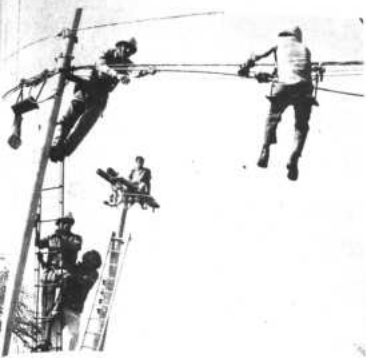
En forma intensa, trabajadores de la Empresa Nacional de Electricidad Cruz, hoy, la primera planta eléctrica que trabaja en base a gas licuado, entrará oficialmente en funcionamiento.
