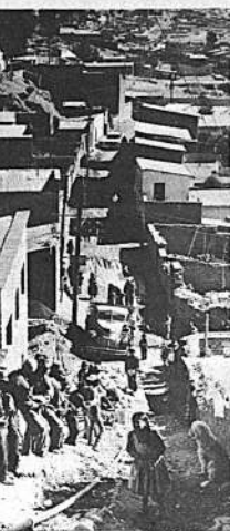
Formando una "fila india", los vecinos de la zona "Jucumilla", trasladan piedras destinadas a la construcción de un tanque para almacenamiento de agua. Los trabajos se cumplen bajo dirección técnica del Programa de Acción Comunal.
