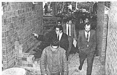
Los Ministros de Educación, Mariano Baptista; y de Urbanismo, Rolando Aguilera, inspeccionaron los trabajos de construcción del nuevo edificio destinado al Liceo de Señoritas "Francisca". Otros locales en construcción fueron también visitados con el propósito de acelerar su ejecución.
