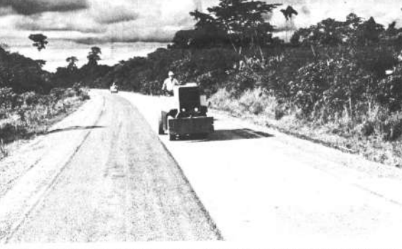
Trabajos de tratamiento superficial asfáltico, en el kilómetro 164 de Villa Tunari hacia Cochabamba.
