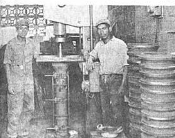
Maquinarias que son empleadas en la construcción de bloques de cemento.
