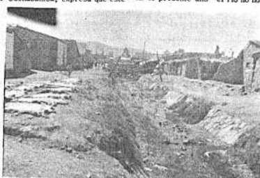
Los canales a cielo abierto constituyen un permanente foco de infección. En las orillas también se han construido viviendas.
