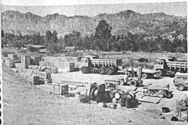
Parte del material y equipo recibidos para la construcción de la Fábrica de Cemento COBOCE en Cochabamba.
