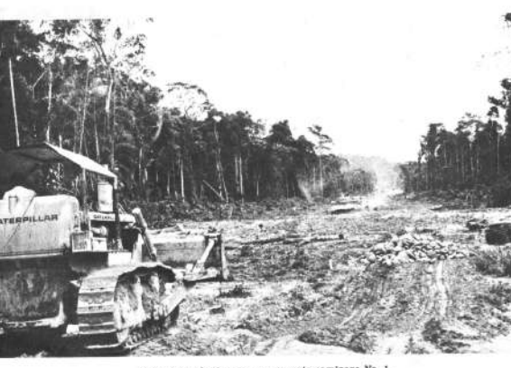
Movimiento de tierras, en proyecto caminero No. 1
