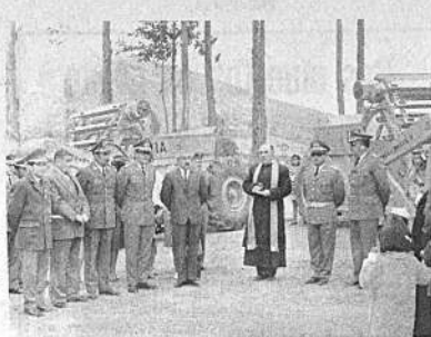
El R.P. Luis Delors, Capellán de la Unidad, bendice las nuevas moto-trailas, con las cuales el Batallón 9 de Ingenieros continuará hasta su conclusión los trabajos del nuevo aeropuerto de Sucre.
