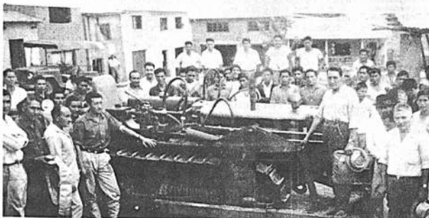
El mismo tractor, ya reparado, se encuentra listo para empezar a trabajar.
