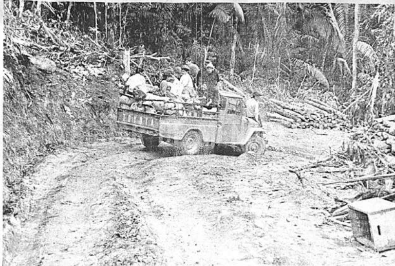
El 7 de junio los vehículos empezaron a transitar por la ruta Guanay-Tipuni. No se trata de caminos modernos, sino de vías por las que puedan transitar camiones de hasta dos toneladas. La construcción del tramo resultó un éxito, con la participación de las poblaciones de la zona y, a raíz de ello, surgió una organización que tratará de vincular a todas las localidades pequeñas del Alto Beni.
