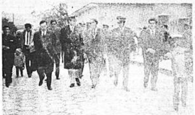
La Comuna tarifeña procedió a la entrega - en ceremonia especial- del enlosado de tres cuadras en la Avenida 15 de Abril. La obra es parte del plan piloto de enlosado del centro de la ciudad.
