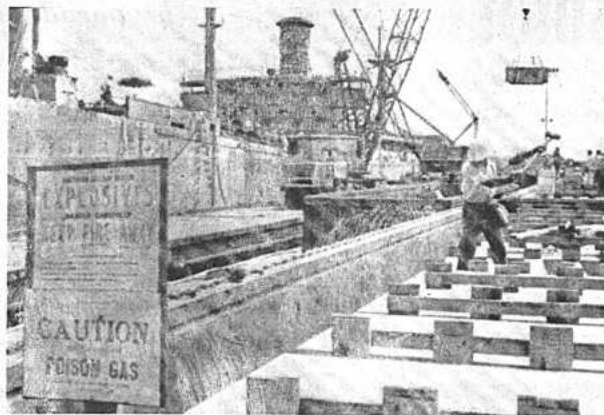
PROBLEMA DEL GAS LETAL. Un estibador abre un vagón que contiene envases del mortífero gas que afecta los nervios para iniciar su carga al barco que lo llevará al Atlántico, donde los envases de acero y cemento, juntos con el barco, serán hundidos a más de 400 kms. al este de Cuba Kennedy, Florida. (Sunny Point, Carolina del Norte, AP WIREFOTO)
