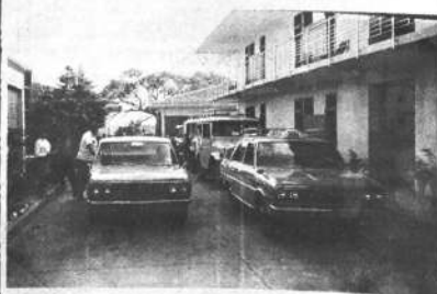
VISTA PARCIAL DE PARQUEO FRENTE A SUS HABITACIONES
