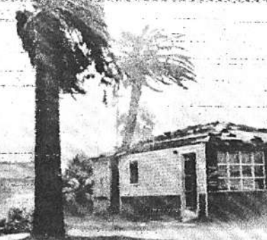
DESTROZOS DEL HURACAN "CELIA". El techo de esta casa y los árboles a su alrededor muestran la fuerza del huracán "Celia" al azotar la costa del estado de Texas con una velocidad de 220 km. por hora. (Amosas Paz, Texas, RADIOFOTO AP)
