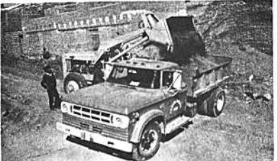
En la ciudad de Potosí, la Municipalidad ha ingresado a una etapa de aceleración de obras, gracias a la donación de nuevos e zulos y maquinaria que han sido donados por la Sra. Elsa Umate de Ovando.
