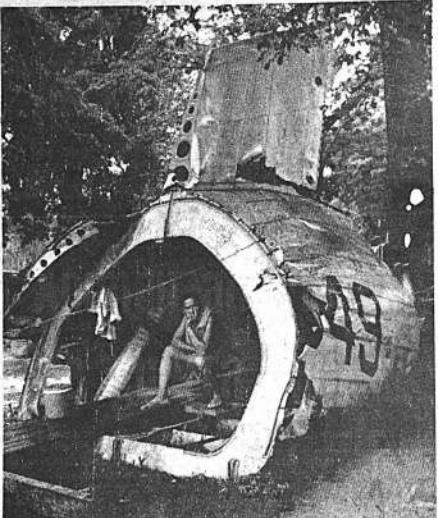
PARTE DE AVION COMO CASA. Un soldado camboyano se sienta en la hamaca de su “casa” -la parte trasera de un viejo avión, DC-3- en la base militar de Kompong Cham, a unos 80 kilómetros al noreste de Phnom Penh. No se sabe de dónde venía el avión. (Junio 10, Radioto AP)
