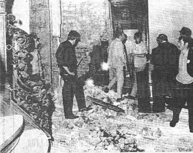
¡ATENCIÓN! Funcionarios policiales observan los daños ocasionados en la sede central de la Policía de Nueva York por una bomba que estalló en el segundo piso del edificio. Varias personas resultaron heridas en la explosión. (Nueva York, junio 10, Radioto AP)
