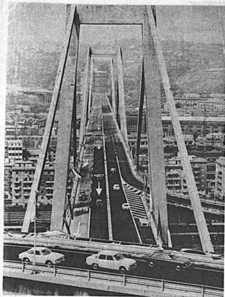
El imponente y moderno viaducto, sobre la ría Polvoca, recién abierto al tráfico en Génova.
