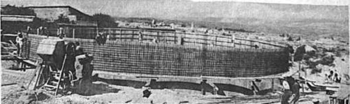
Terminada la enfierradura para colocar el encofrado y posterior vaciado de la segunda parte del Estanque de la Red Baja que junto a la Red Media, distribuyen en agua a la Ciudad. Estos estanques tienen un diámetro de 26,00 mts. y 5,20 mts de altura con capacidad de 2,000,00 M3 (dos millones de litros.)
