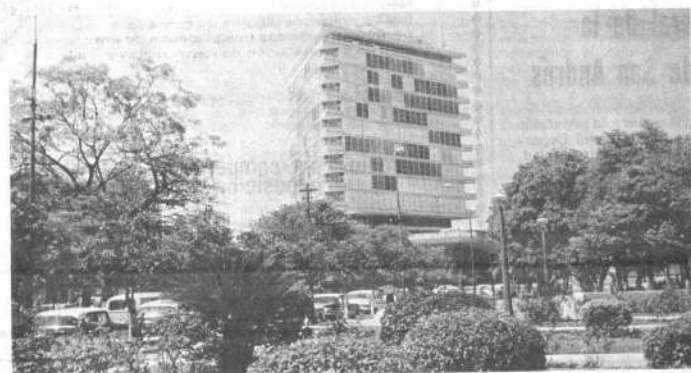
Vista del Edificio del Gran Hotel Guarani ubicado en el centro mismo de la ciudad de Asunción.
