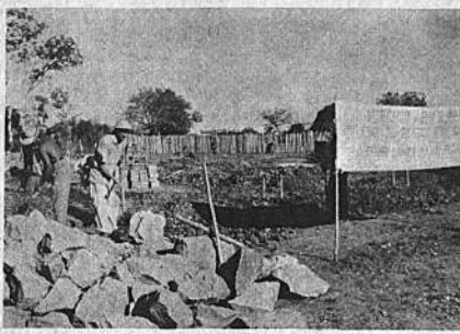
"Una obra del pueblo para el pueblo" expresa el cartel colocado en el lugar donde Acción Cívica del Grupo Lanza y la Alcaldía, construyen en Puerto Suárez un mercado popular. (FOTO PRESENCIA).
