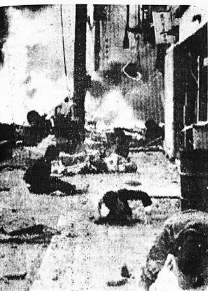
EXPLOSIONES DE GAS CAUSAN 88 MUERTOS.- Las víctimas de una de las explosiones de gas producida en Osaka, Japón, yacen en la calle, mientras esperan la llegada de auxilios. Una serie de explosiones destruyó la obra de construcción de un tramo de ferrocarril subterráneo hoy al ataque. Las primeras informaciones decían que habían 88 muertos y 307 heridos. Las explosiones se produjeron a la hora de mayor actividad en la ciudad de 3 millones de habitantes (Osaka, Japón, abril 8 Radiofoto AP)
