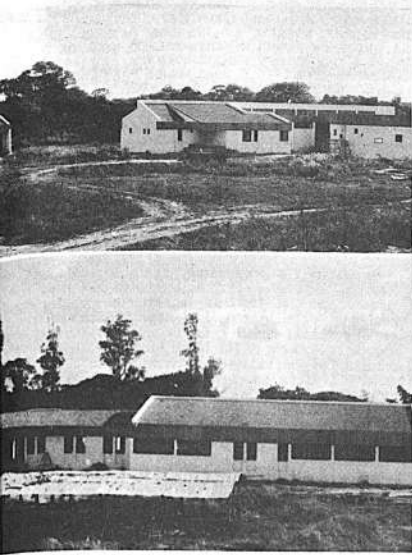
En la vista del departamento de Anatomía y Patología, a la izquierda, un pequeño pabellón "Lazareto", para tratamiento de animales enfermos. (FOTO NIRKA). En la vista frontal del departamento de clínicas. Será terminado de construir en días más. (FOTO NIRKA).
