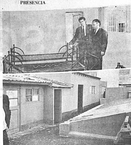
La fotografía superior muestra al Director General de Tránsito, Cnel. Jorge Salazar, inspeccionando las nuevas celdas de Tránsito. Una vista parcial de la terraza del edificio, donde fueron construidos los nuevos calabozos.
