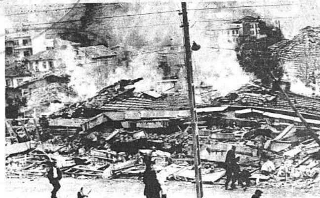
TERREMOTO EN GEDIA.- Algunos sobrevivientes del trágico terremoto del sábado pasado caminan en una calle donde se ven los escombros de un edificio que se desplomó a causa del terremoto. Según informes oficiales de carácter provisional fueron encontrados los cadáveres de 867 personas. Radioto A.P.
