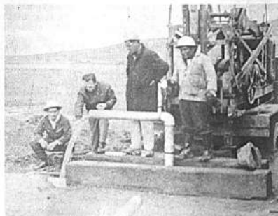
Un grupo de técnicos de CORPAGUAS realizando los trabajos de perforación de pozos de agua para las distintas poblaciones del país.
