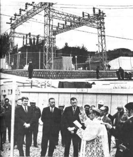
Una vista general de la Subestación de energía eléctrica instalada en la esquina formada por las calles Rosendo Gutiérrez y Capitán Ravelo, cerca de la Avenida Arce. Abajo, el Arzobispo de La Paz, Monseñor Jorge Manrí, bendice las nuevas instalaciones en presencia del Alcalde Municipal, Gral. Hugo Suárez Guzmán, y representantes de la Compañía Boliviana de Energía Eléctrica.
