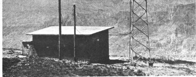
Antena de microondas instalada en la cabaña de El Alto, que permite el enlace entre la planta de Achacicala y el centro de operación de la Avenida Camacho.
