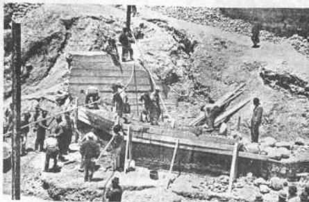
Vecinos de Tembladerani, sector Cota-Huma, construyen un puente vehicular bajo el programa de Acción Comunal, como una contribución a la solución de problemas que afectan a las zonas marginales de la ciudad de La Paz.
