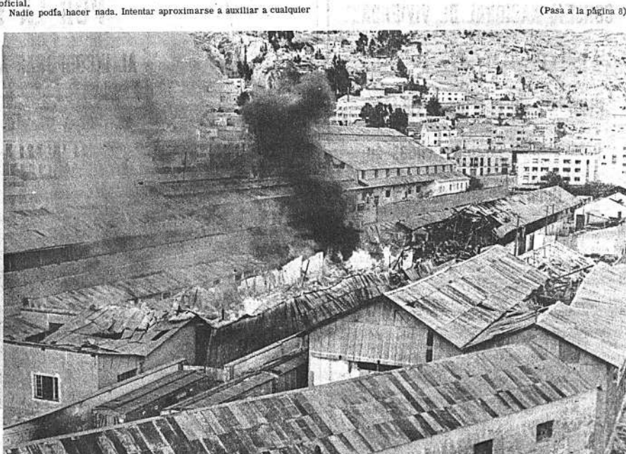
ESCENARIO DEL HECHO. - La densa humareda negra se desprende del local del arsenal. En la parte posterior, aparece el edificio de la Aduana que también resultó seriamente afectado. Al pie de la fotografía, el edificio de la Estación Guayaquil. La fotografía fue lograda desde el edificio de la Carceraria, a poco menos de 100 metros del sitio del desastre. Techos hundidos, paredes desplomadas, hierros retorcidos, humo y penetrante olor a pólvora dominaban todavía hasta anoche todo el sector de la zona norte. Información completa en las páginas centrales.
