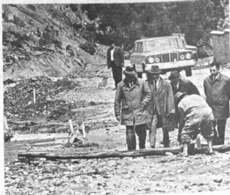
El Alcalde Suárez Guzmán ha intensificado sus visitas de inspección a los sitios de la ciudad amagados por deslizamientos y riadas provocados por las últimas lluvias. La fotografía muestra al jefe de la Comuna, acompañado de dos ingenieros, observando los trabajos provisionales que se han venido realizando en varios riachuelos que se desbordaron.
