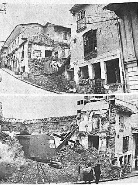
Después de una larga indecisión, en autoridades municipales, se inició la demolición de la "Casa del Loro", en la calle Colón, edificio ruinoso de la época colonial y donde se alimna vivió el Libertador Simón Bolívar. Una pala mecánica ha comenzado la demolición de las gruesas paredes de adobe del edificio. Esa casa se había convertido en un conventillo que después fue desajado porque el techo iba a hundirse de un momento a otro y las paredes que daban a la calle amenazaban con desplomarse en cualquier momento. Allí, donde se dice vivió Bolívar, se levantará un edificio de doce pisos que contribuirá a embellecer y modernizar a la ciudad de La Paz.
