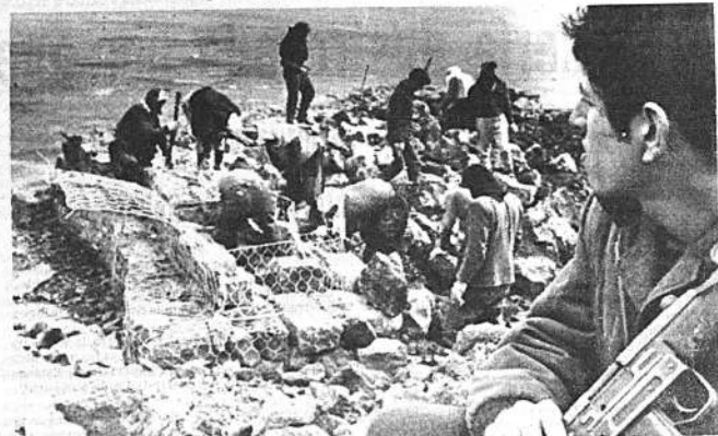
LEVANTANDO FORTIFICACIONES. Mientras un soldado israelí hace guardia, varios trabajadores construyen una fortificación en la colina 965 ubicada a 35 millas de Damasco. (Radiofoto AP)
