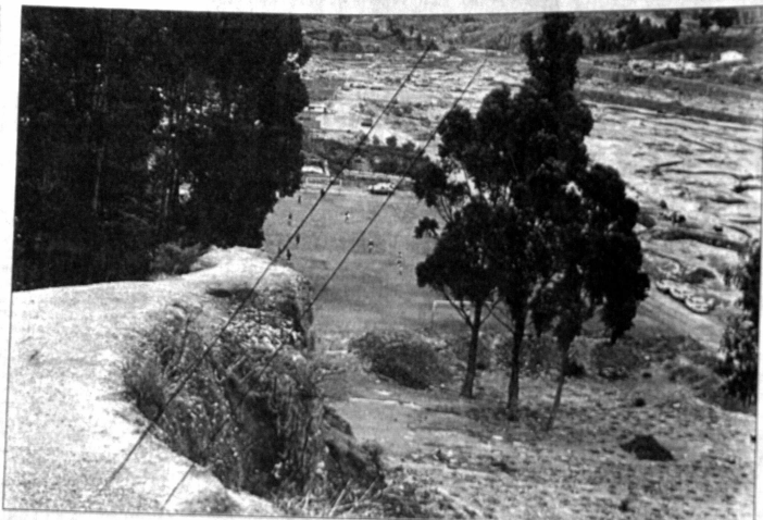
Este es el playón de Irpavi donde se pretende desviar el río hacia dos urbanizaciones.
