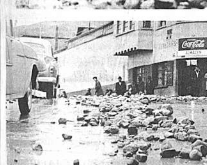
El riachuelo de la calle Beni, en proceso de canalización, aumentó de caudal debido a la obstrucción de los canales de desagüe. Las cajas de control fueron limpiadas por cuadrillas de obreros municipales y carabineros. El trabajo de canalización fue paralizado hace cinco meses "por falta de pago" al contratista (foto superior). La riada llegó a cubrir totalmente la canalización con piedras, arena y lodo. Durante varios minutos, el tráfico quedó paralizado en la esquina de las avenidas Perú y Arce (foto inferior).
