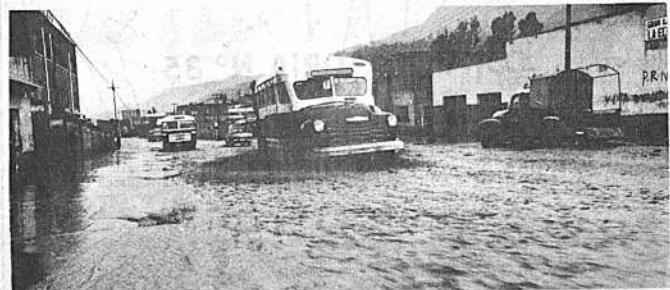
En la zona de Villa Fátima hubo deslizamiento de una parte de un cerro. Barro y piedras cubrieron la avenida final Tejada Sorzano. Los vehículos que por allí transitaban se entorpecieron. Las bocas de tormenta quedaron inutilizadas temporalmente por el lodo y las piedras.
